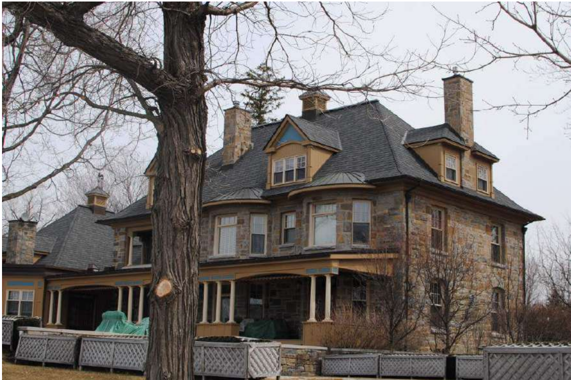
Façade Arrière Droite :
